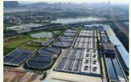
廣州海滔永和污水處理廠
